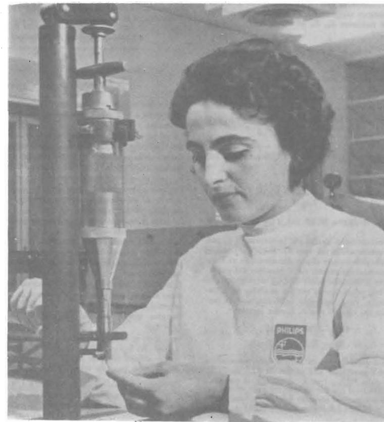
Preparazione dei palloncini di vetro per un determinato tipo di transistor.
